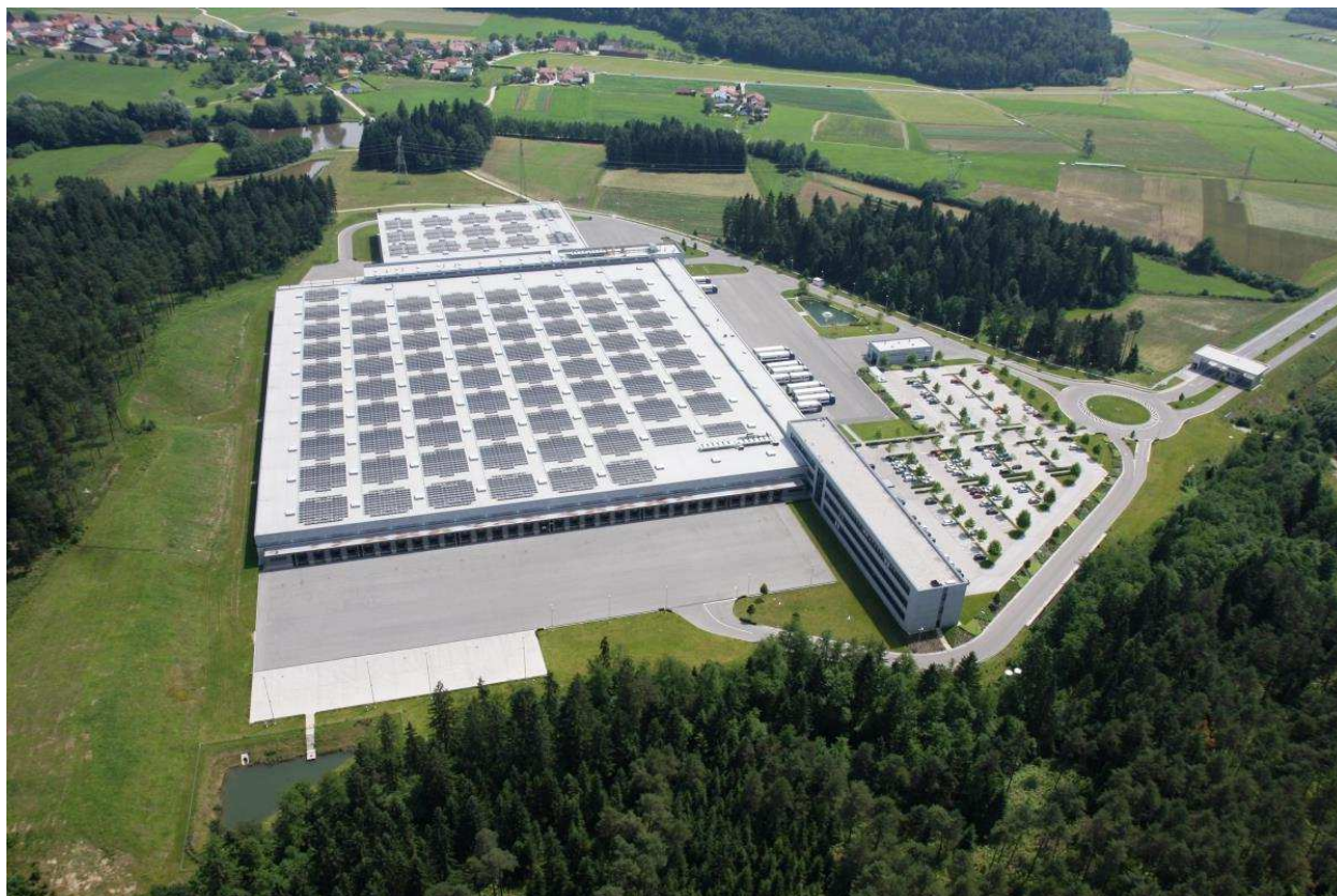
Slika 32: Sončna elektrarna na strehi podjetja Hofer vir: https://www.hofer.si
