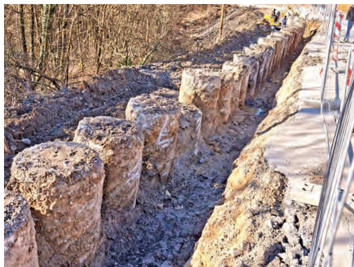
Sanacija plazu Obrše.
