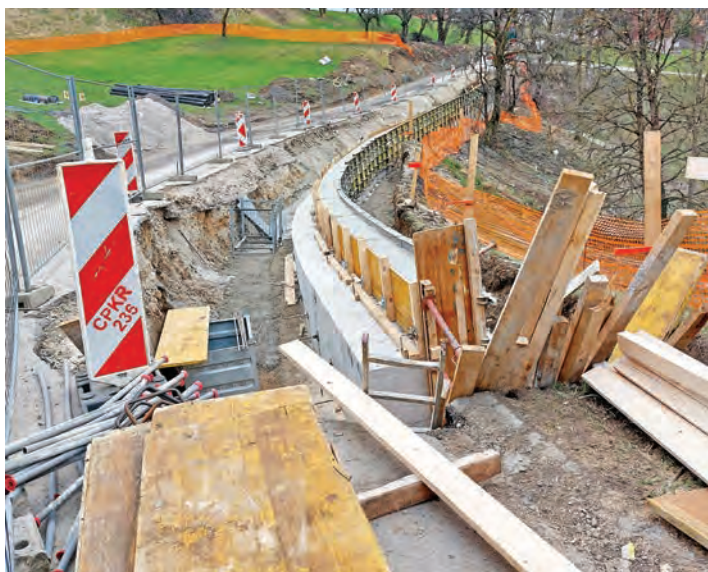
Sanacija plazu Čeplje.
