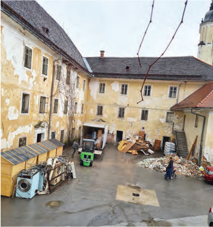
Iz ogromnega poslopja so prostovoljci odpeljali več kot 15 ton odpadnega materiala.
