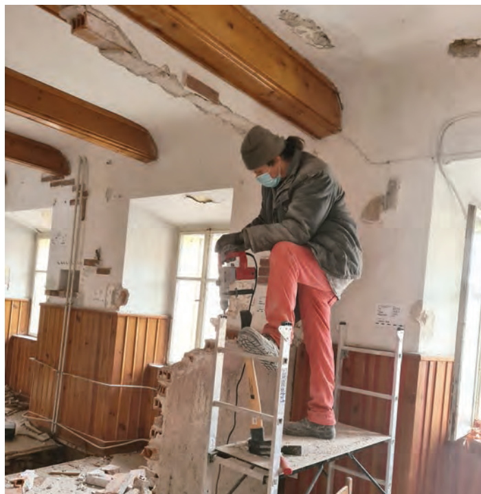
Grof v delovni opravi pri rušenju pregradnih sten.
