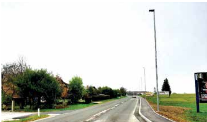
Zaključena je izgradnja pločnika ob regionalni cesti R2-447, odsek 292 (Trojane – Želodnik).
