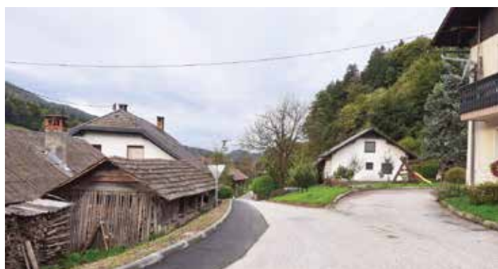
Ureditev meteornege odvodnjavanja v Zgornjih Lokah.
