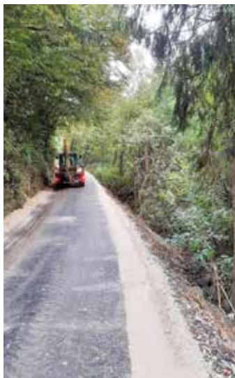
Sanacija usada cestišča na cesti Mala Lašna.
