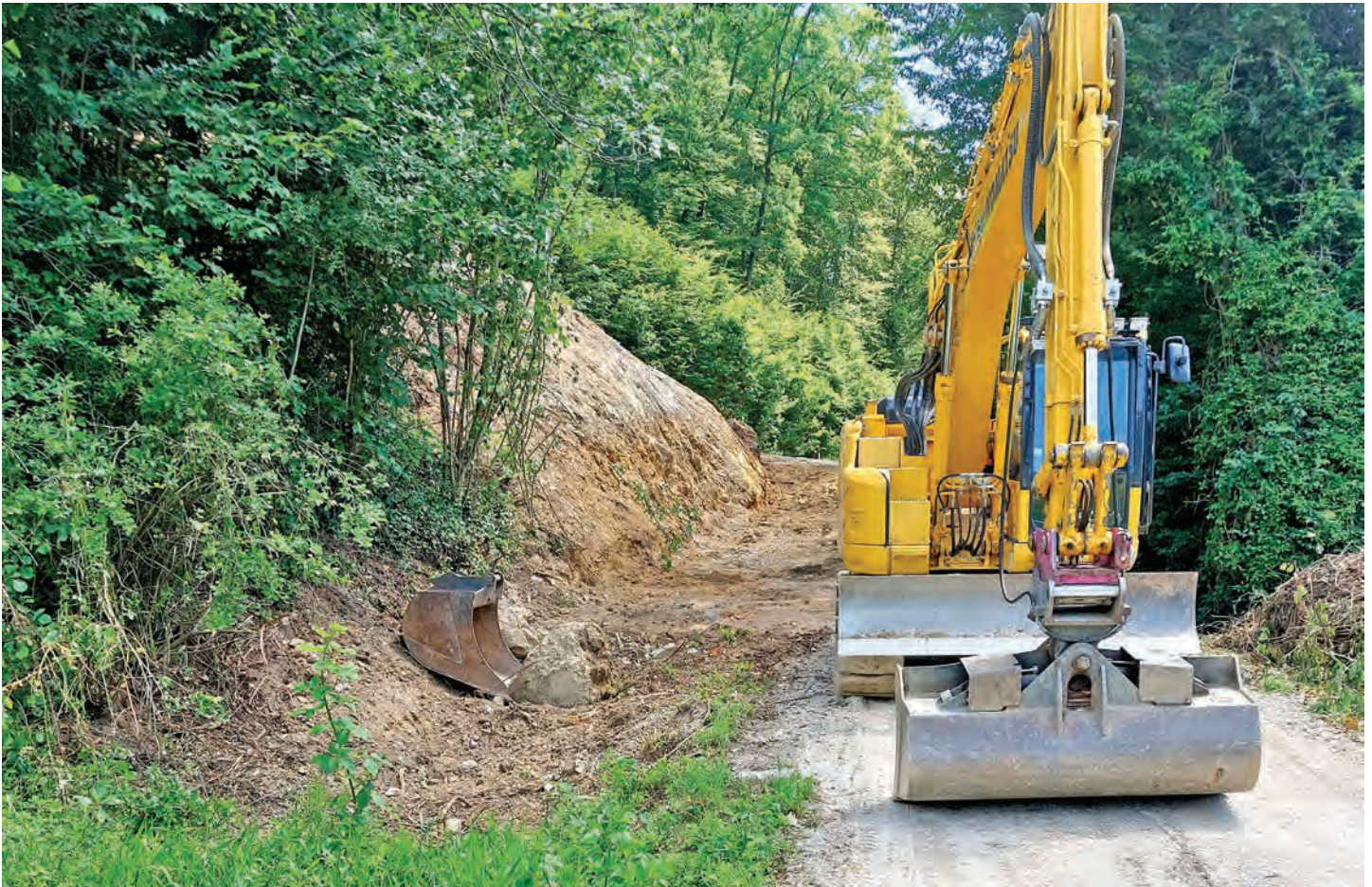
Urejanje dostopne poti do poslovilnega objekta v Krašnji.
