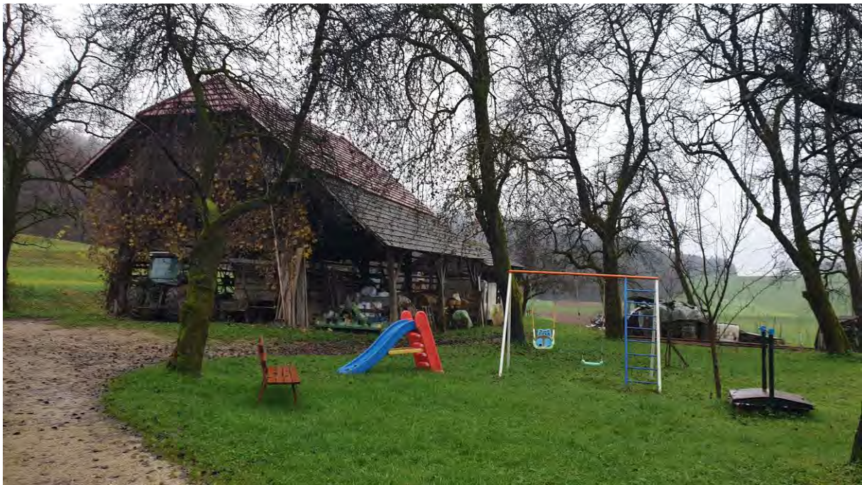
Slika 10: Fotografija objekta, ki se ga ruši zaradi gradnje novega objekta (spogled proti zahodu)
