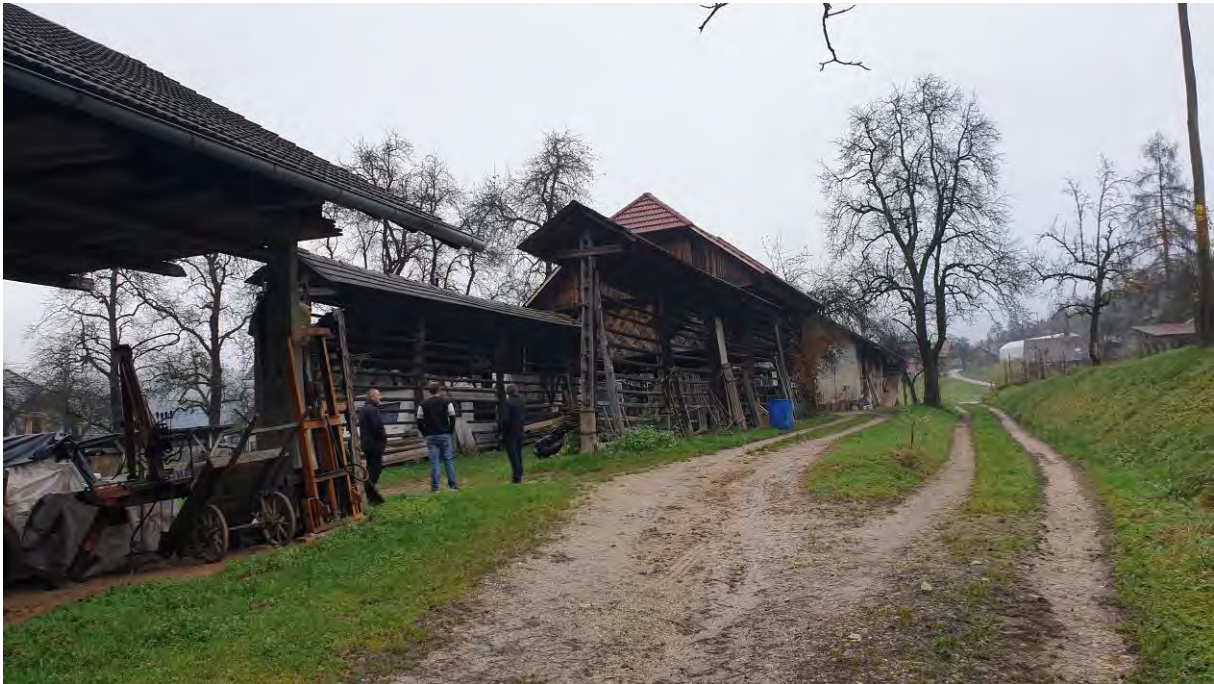
Slika 11: Fotografija objekta, ki se ga ruši zaradi gradnje novega objekta (pogled proti vzhodu)
